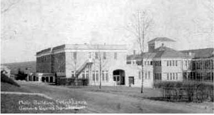
Şekil -1.14. Berkeley tepesinde yer alan Bonnie Burn sanatoryumu,1912. Hastane 1991'de restore edilerek bu günkü modern Runnels İhtisas hastanesine dönüştürülmüştür.
